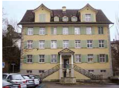
Musste dem Leuenhof weichen: Das Haus Zum Brunnen steht heute in der Enge.
